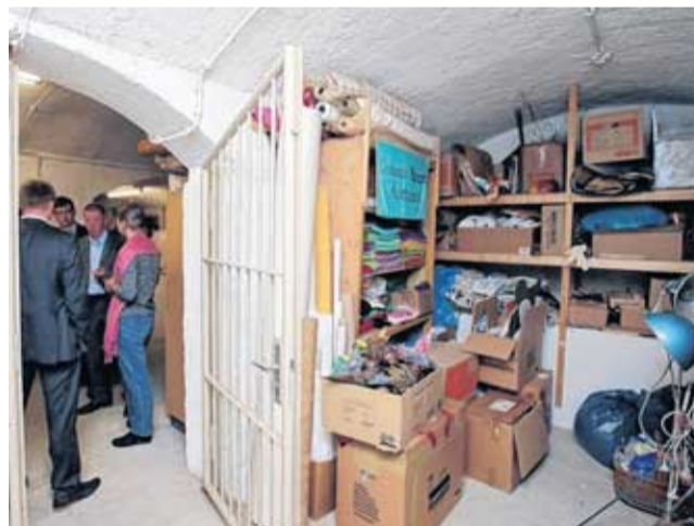
Wie hier ist jeder Winkel im Keller vollgestellt. Aus Sicht des Brandschutzes ein Riesensproblem.
