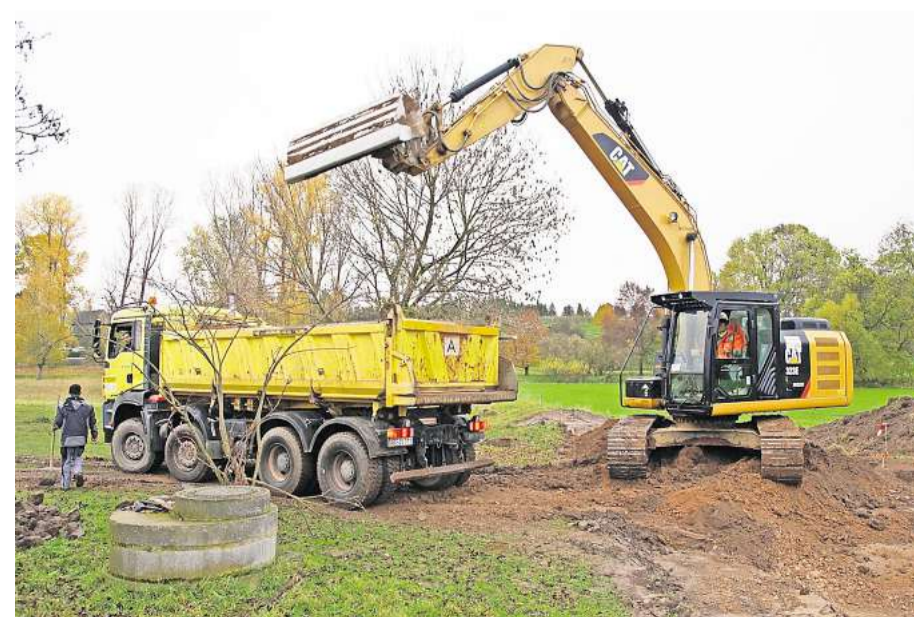
Mit schwerem Gerät wird im Ortsteil Knau der Schutzwall geschlossen. Foto: Ronny Seifarth
