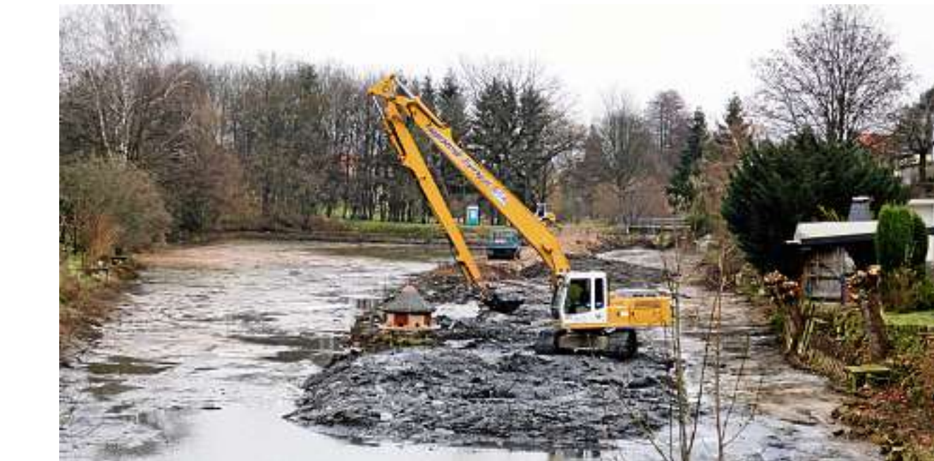
Die Schlammung des zweiten Dorfteiches läuft. Gut zu beobachten sind die Arbeiten von der neu gebauten Brücke aus.
