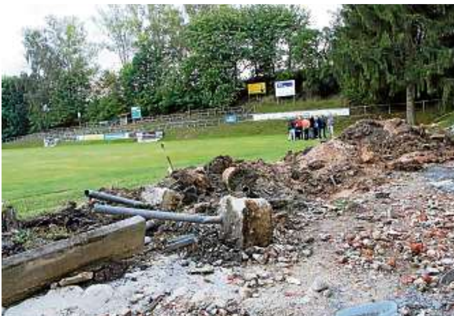
Sondersitzung mit Vor-Ort-Termin: Vor einer Woche tagte der Technische Ausschuss auf der Baustelle für die neue Sportstätte in der Sommeritzer Straße. Foto: Jana Borath
